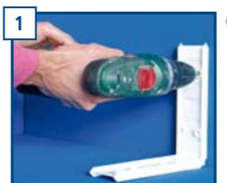
**FR** Couper une croix en forme de L (photo A) et l'encastrer avec les profils en correspondance de la fissure qui indique la brique de verre choisie (Pegasus ou Basic) jusqu'à former un angle droit. En correspondance des trous présents sur le profil, dessiner les points qui servent sur le sol et sur le mur et faire les trous avec la perceuse. Insérer les chevilles et visser la structure en équerre réalisée auparavant avec VetroCLICK (photo 1).
